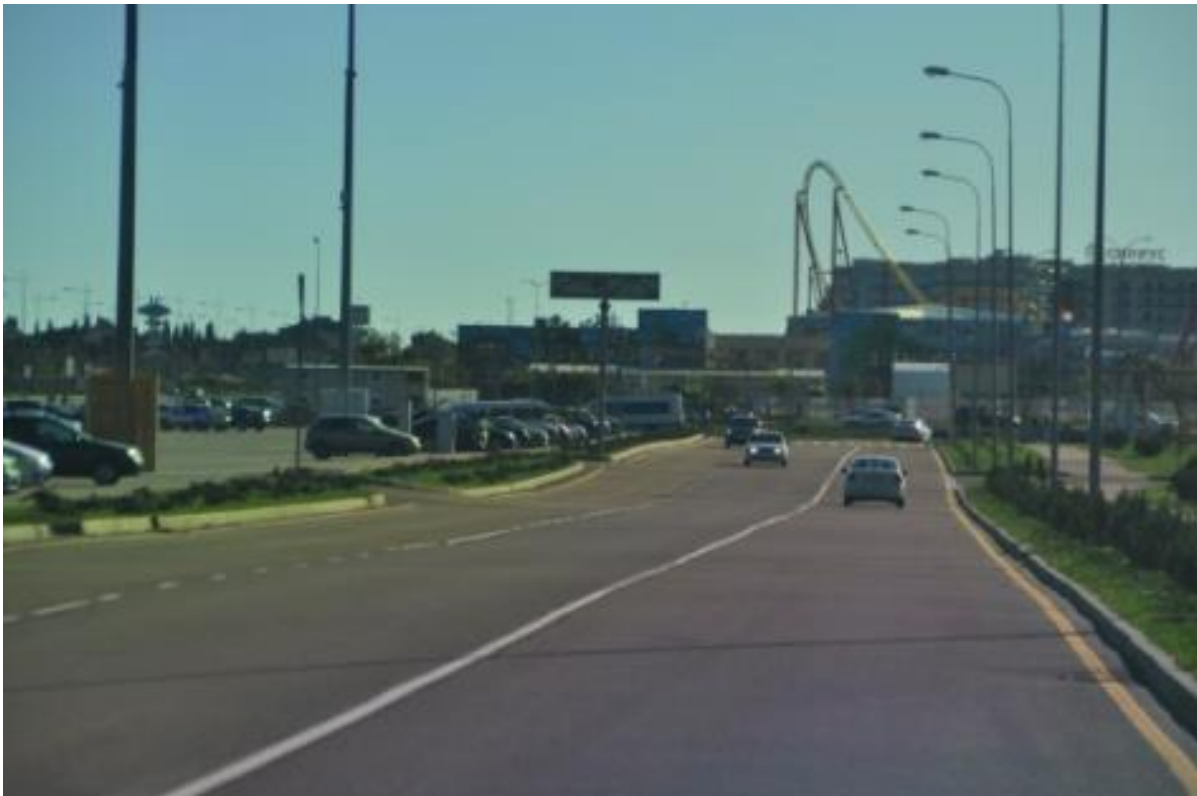
Рис. 1. Плавное оседание дорожного полотна (до 1,2м) в результате остаточной консолидации грунтов основания.
