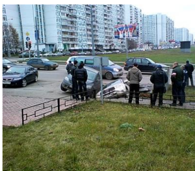
Рис.2. Провал грунта около АЗС на ул. Крылатские Холмы
